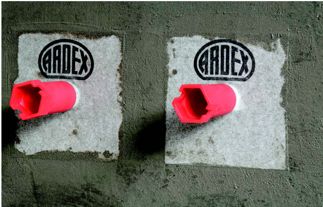
Bild 11: Einarbeiten der Dichtmanschetten
