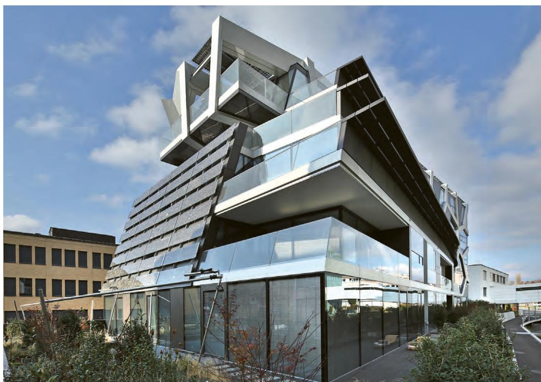
Die Energiemaschine: Die sieben Klimaflügel am Dach des active energy buildings in Vaduz sind Teil einer ausgeklügelten Fotovoltaikanlage mit integriertem Solartracker. Überschüssiger Strom wird ins regionale Versorgernetz eingespeist.
