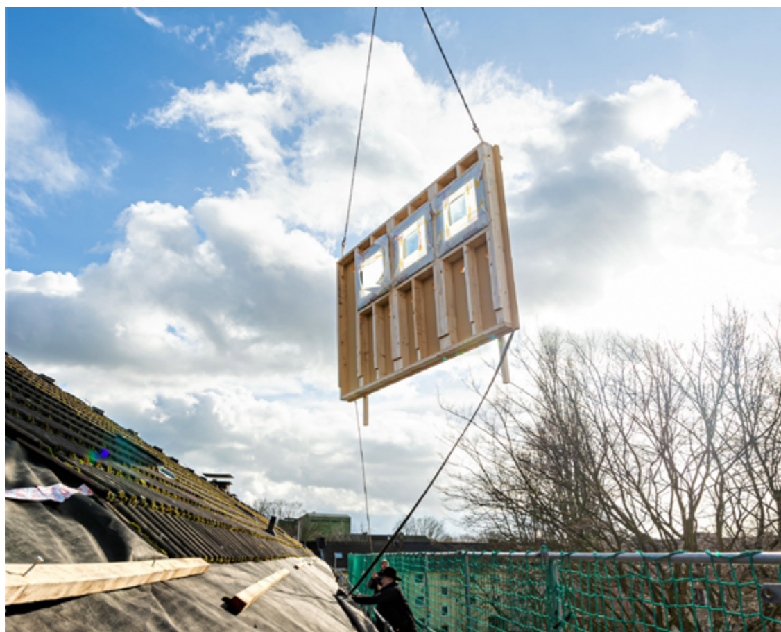
Fassadenelement schwebt auf Baustelle ein. Foto: Vonovia/ Simon Bierwald.
