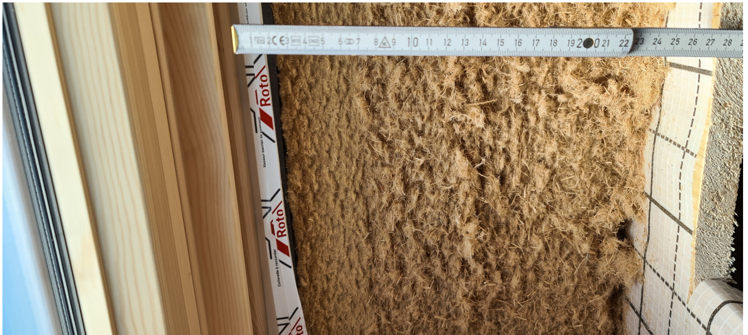
Eine gute Dach-Dämmung ist ein wichtiger Baustein, um bei Modernisierungen den Effizienzhausstandard 85 einzuhalten. Foto: Warda Wohnungswirtschaft-heute
