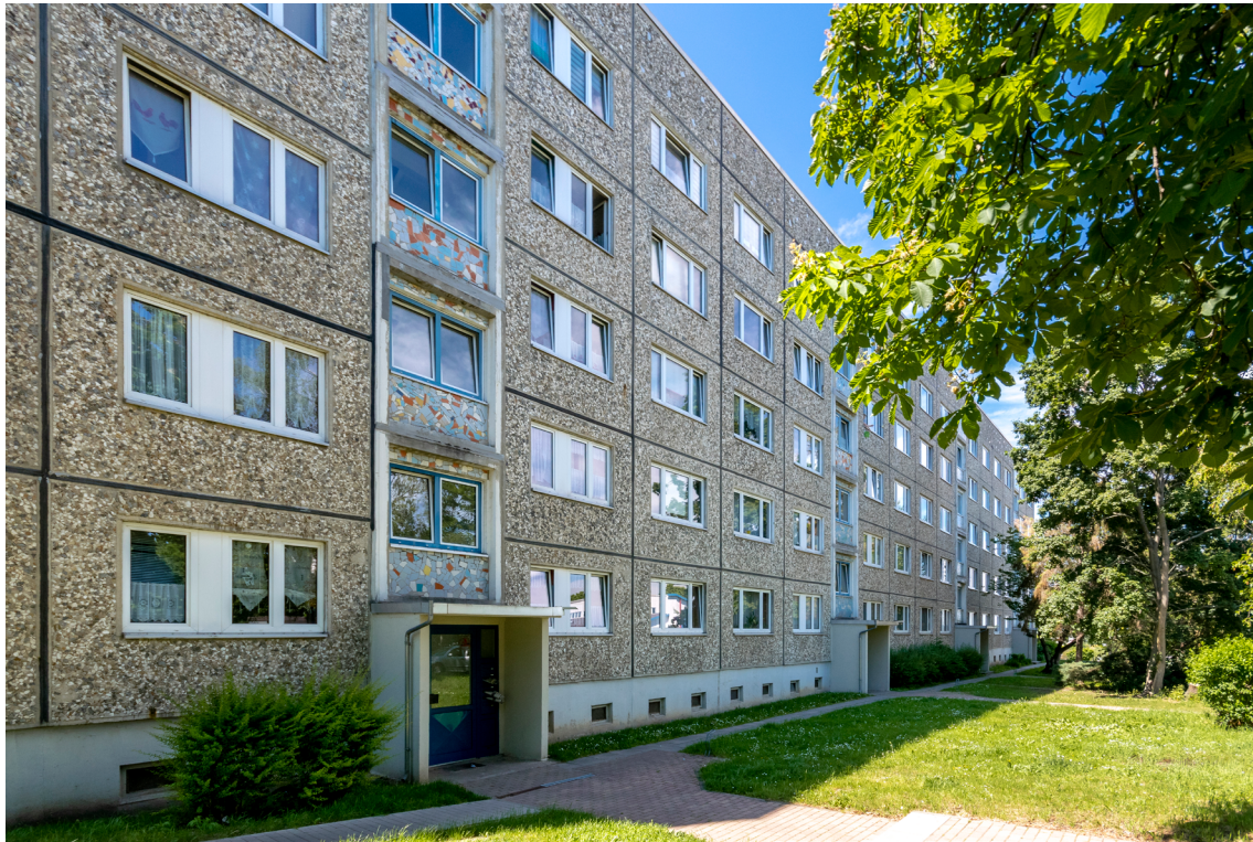
Kopernikusstraße-10-16 b So sah der Plattenbau vor der Sanierung aus. Foto: Ascherslebener Gebäude- und Wohnungsgesellschaft
