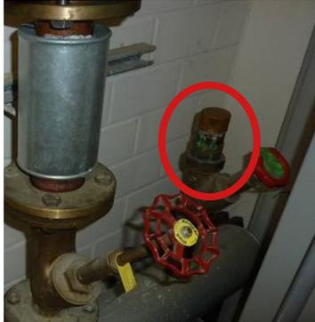
**Bild 1:** Verteiler im Hausanschlussraum mit abgetrennten Stutzen
