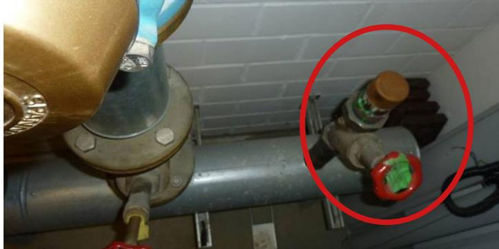
**Bild 2:** Detailbild aus Bild 1, Abgetrennter Stutzen im Verteiler ehemaliger Bauleitung, Rohrbefüllung für Erweiterung bzw. während der Bauphase – Gefahr der Verkeimung, da Stagnationsbedingungen. Dies entspricht nicht den allgemein anerkannten Regeln der Technik!
