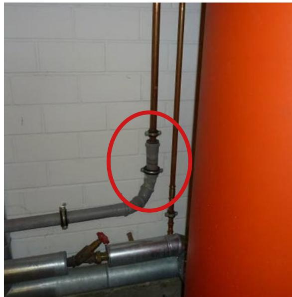
**Bild 3 und 4:** Belüftungsleitungen mit Direktanschluss an die Abwasserleitung – nicht zulässig – Gefahr der Verkeimung
