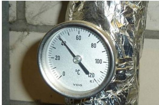
**Bild 5 (links):** Temperaturanzeige bei 40 °C, unterhalb der notwendigen Temperatur, um das mikrobielle Wachstum zu hemmen
